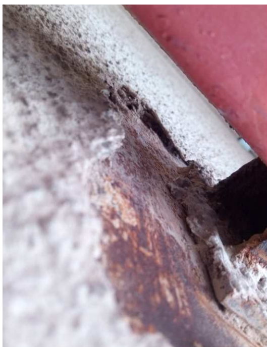
OBR: 12 – Otočený kotevní profil o 180°
