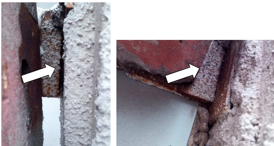
OBR: 07, 08 – Chybějící svary kotevních detailů
