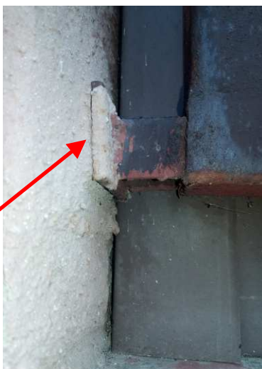
OBR: 14 – Kotvení bez svaru
