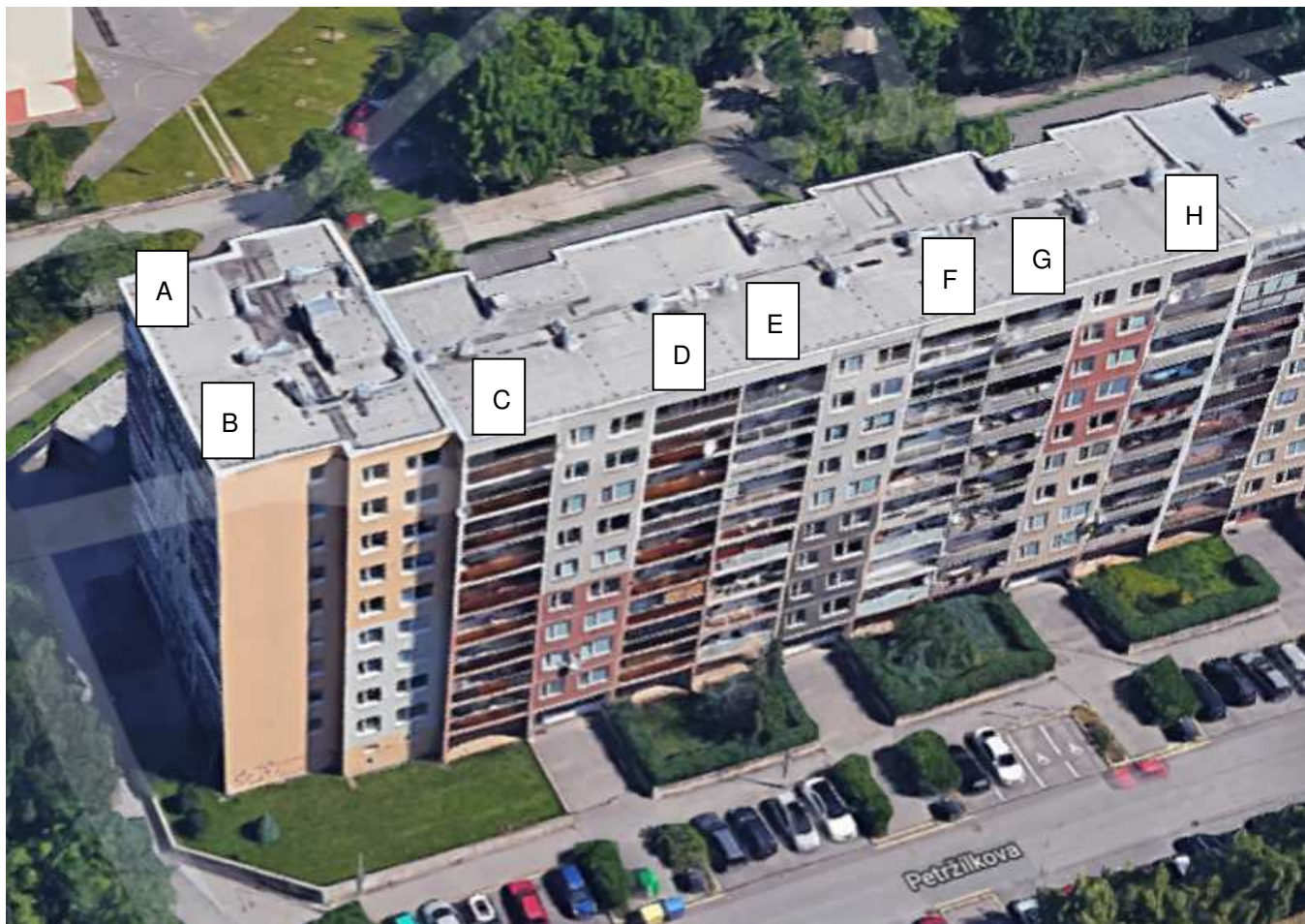
OBR: 04 – Panelový dům v ulici Petržilkova
