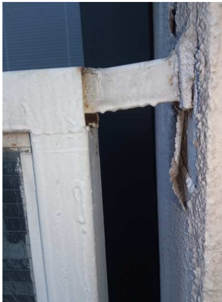
OBR: 15 – Šikmo osazené kotevní prvky
